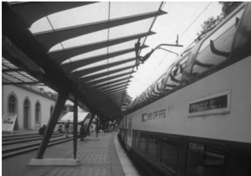
Fig. 15: Platform roof at Bahnhof Stadelhofen, Zürich.
